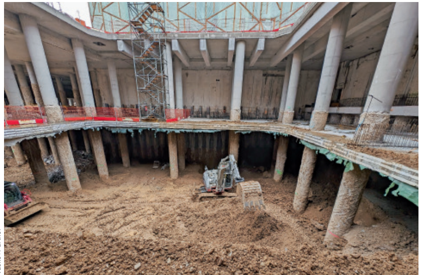
BAUGRUBE MARIANNENGASSE 128 Primärpfähle zur Sicherung der Deckel
