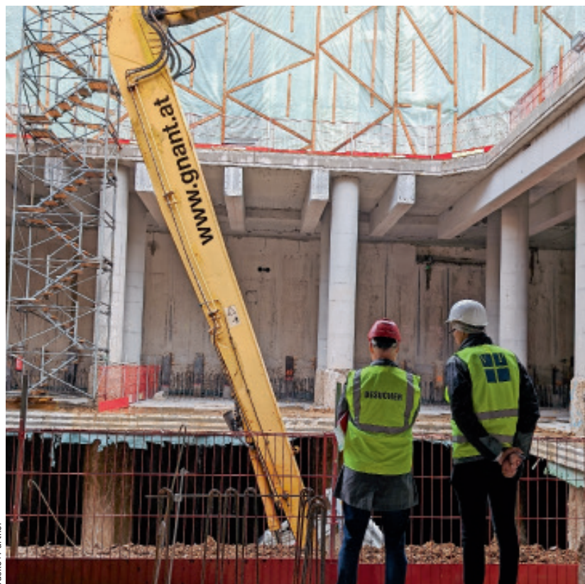
BAUGRUBE Vom Hörsaal 2 ist noch nicht viel zu sehen.
